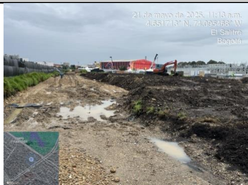
Fotografía 1. Intervención de vía de acceso – excavación e instalación de rajó
